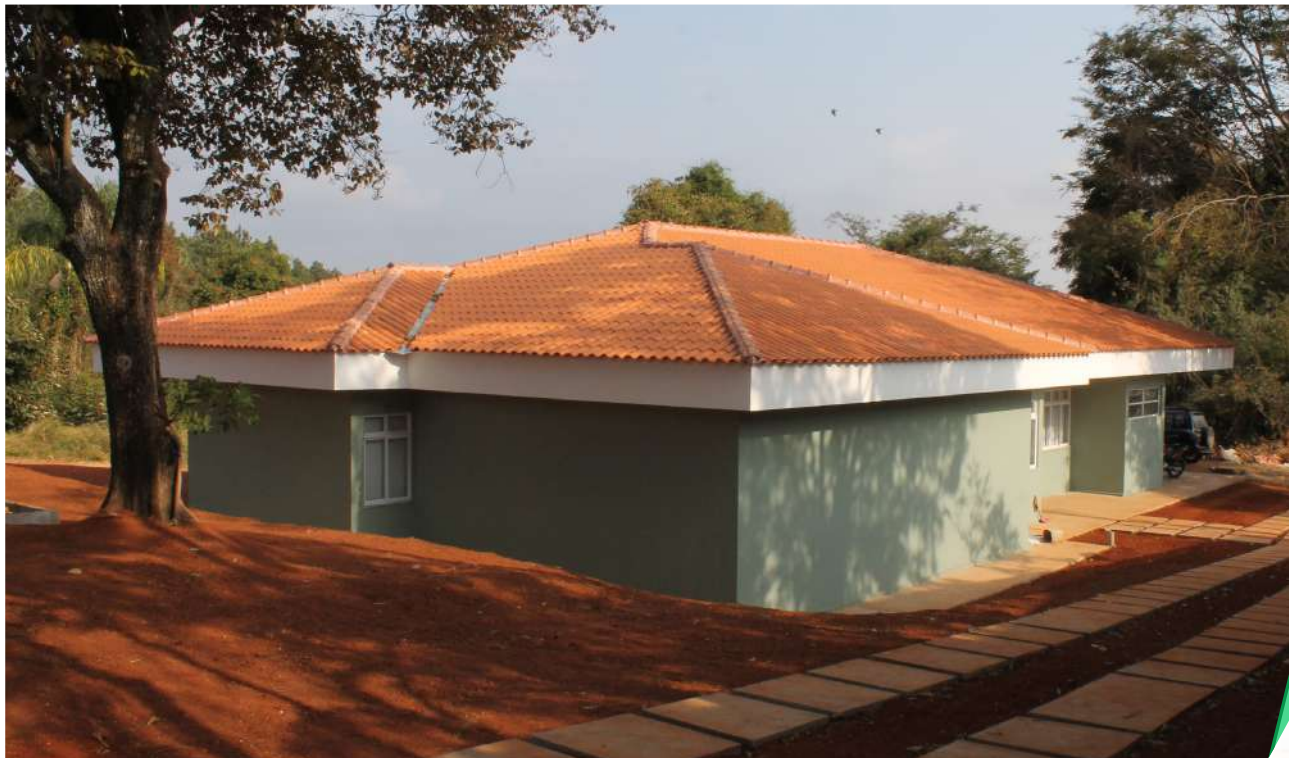
Figura 19 - Construção do Centro de Biologia Subterrânea - DBI.
