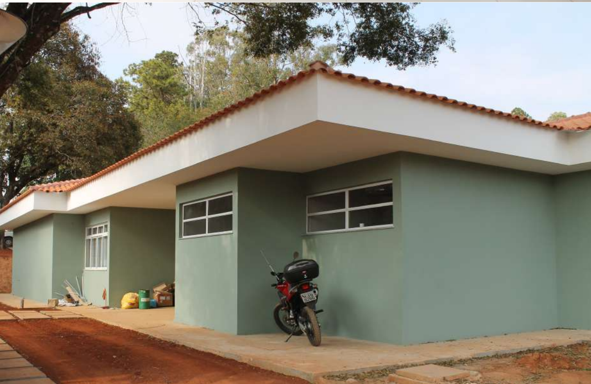
Figura 22 - Construção do Centro de Biologia Subterrânea - DBI.
